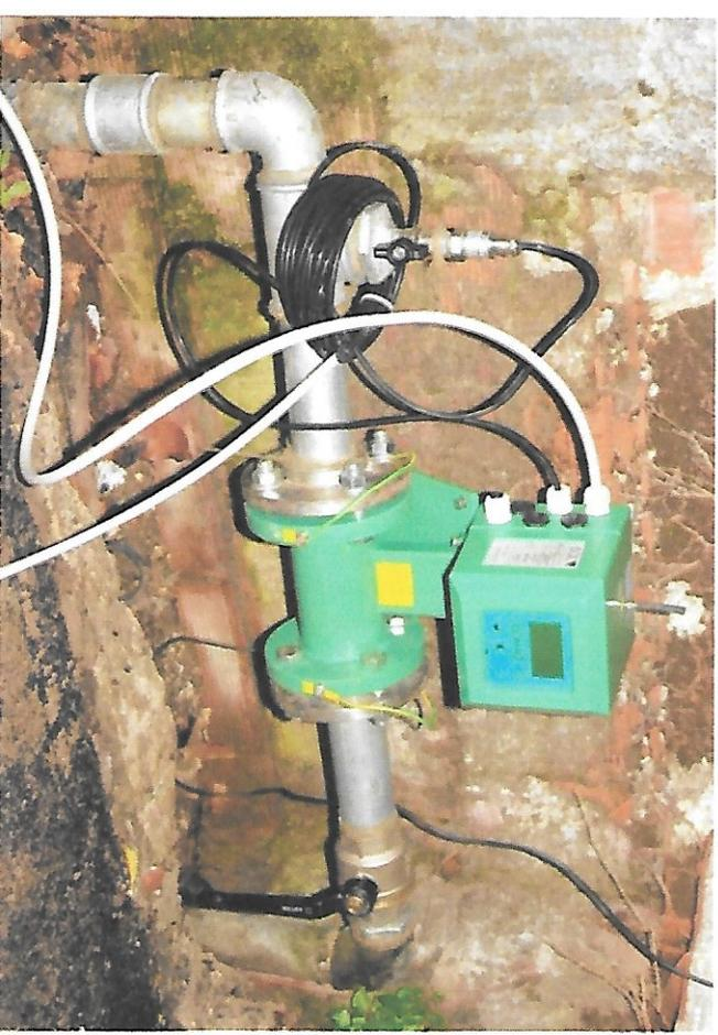
Dopo il primo giorno di monitoraggio si sono potute già escludere perdite in rete a valle del misuratore: si vede che la portata va a zero quando non c'è consumo
